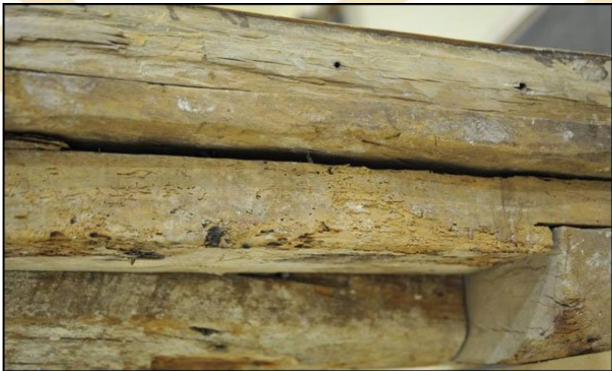
تصویر ۲۹: آسیبهای بیولوژیکی، پشت چهارچوب در. منبع: نگارنده.
