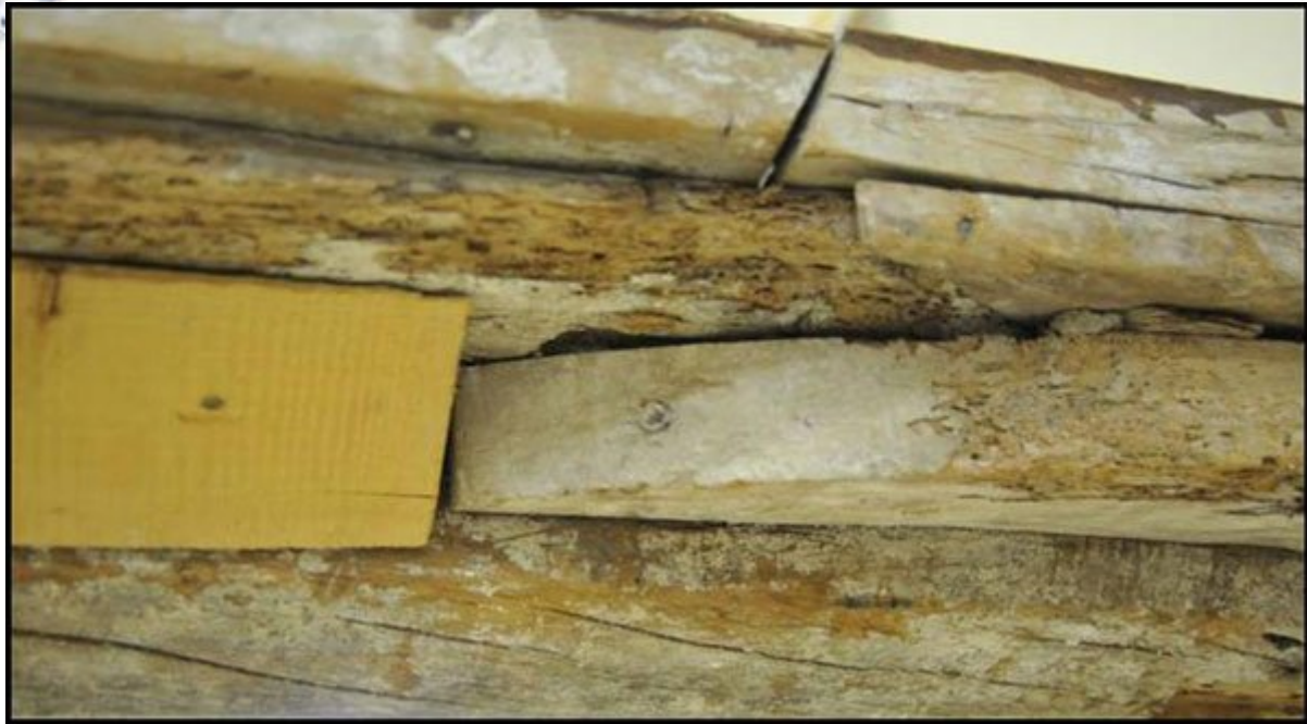
تصویر ۳۰: آسیبهای بیولوژیکی، پشت چهارچوب در. منبع: نگارنده.
